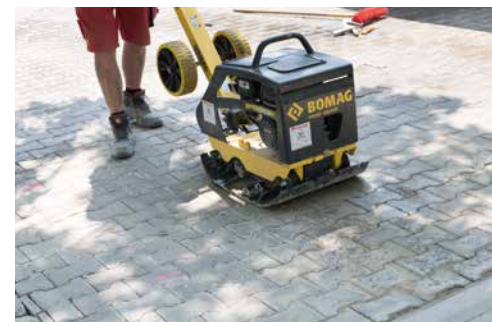
Abrütteln in ungebundener Bauweise
