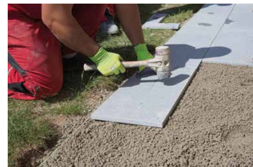
Pflastern in gebundener Bauweise
