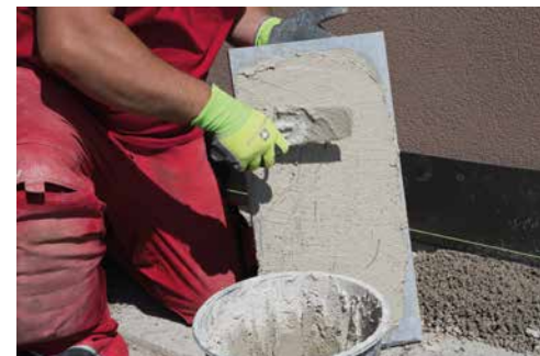
Verkleben in gebundener Bauweise
