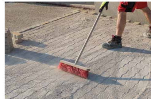
Verfugen in ungebundener Bauweise
