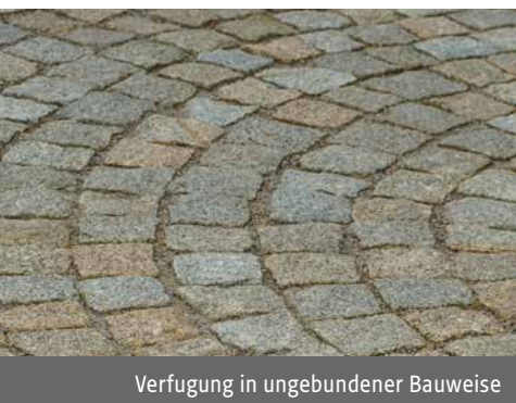
Pflastern in ungebundener Bauweise
