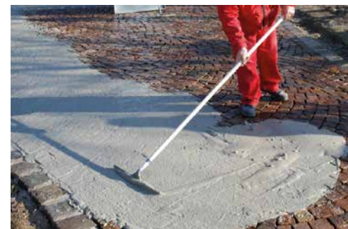
Verfugen in gebundener Bauweise
