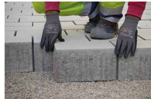
Verlegen in ungebundener Bauweise
